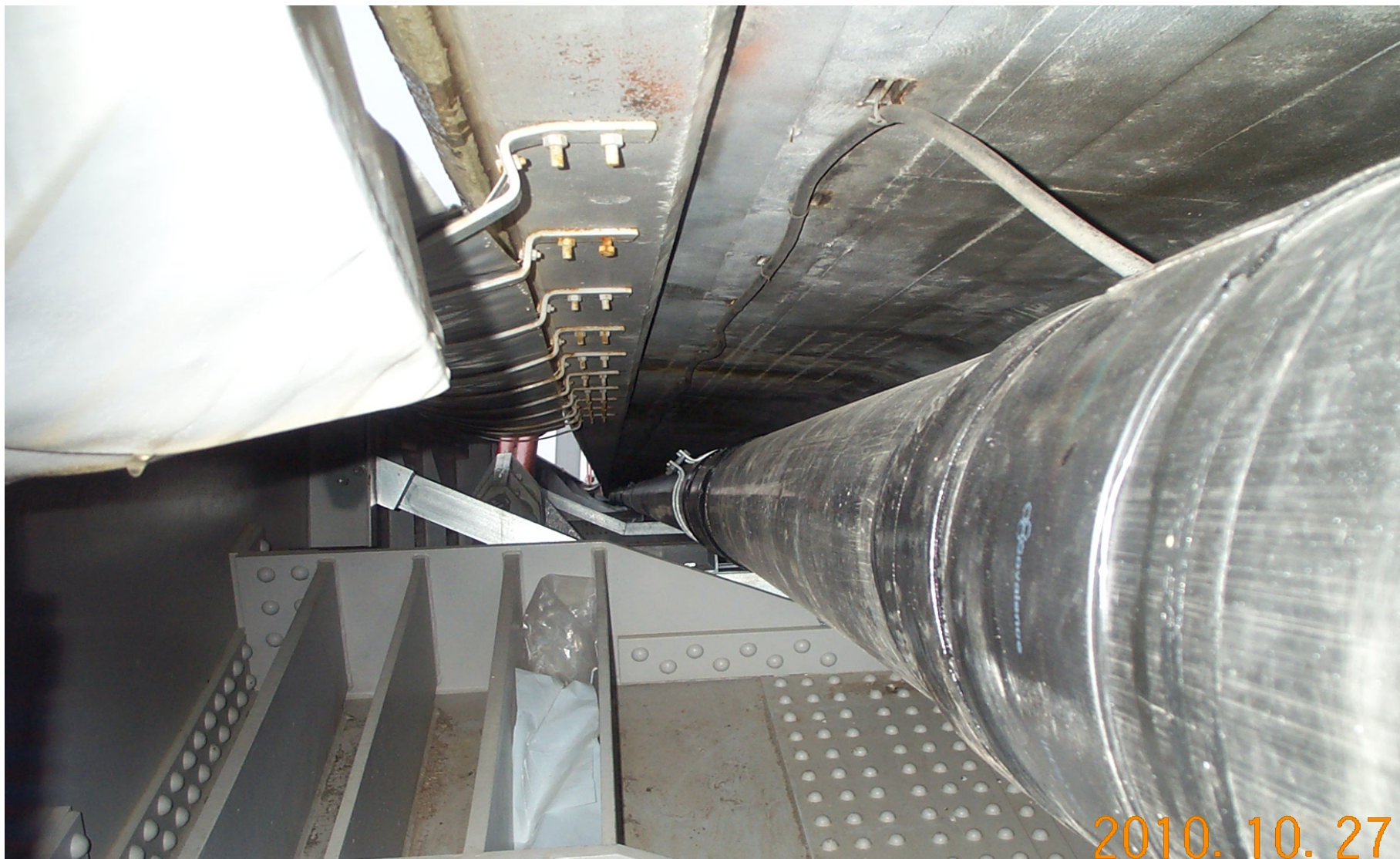
Tajt vid infästningen av linorna för bron.
