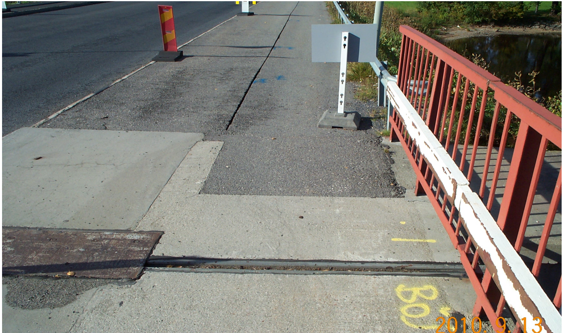
Asfalten skuren för schakt
