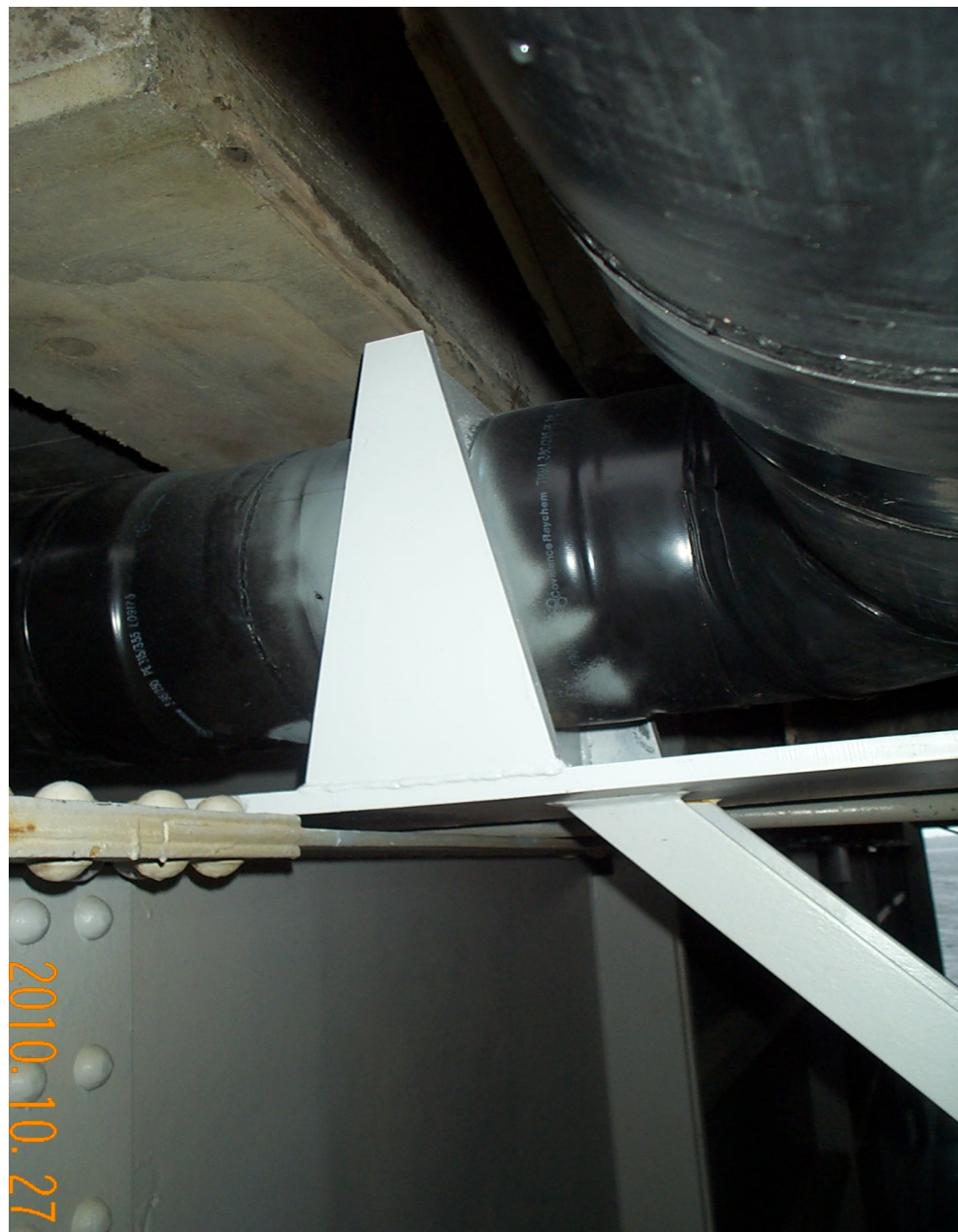
Rörbøjarna med prefabricerade fixar kom direkt från fabrik
