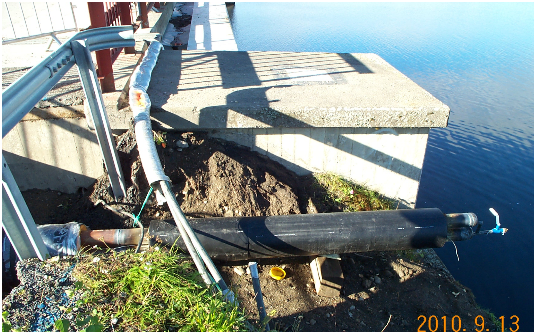
Norra brofästet med korsning av fiberledning
