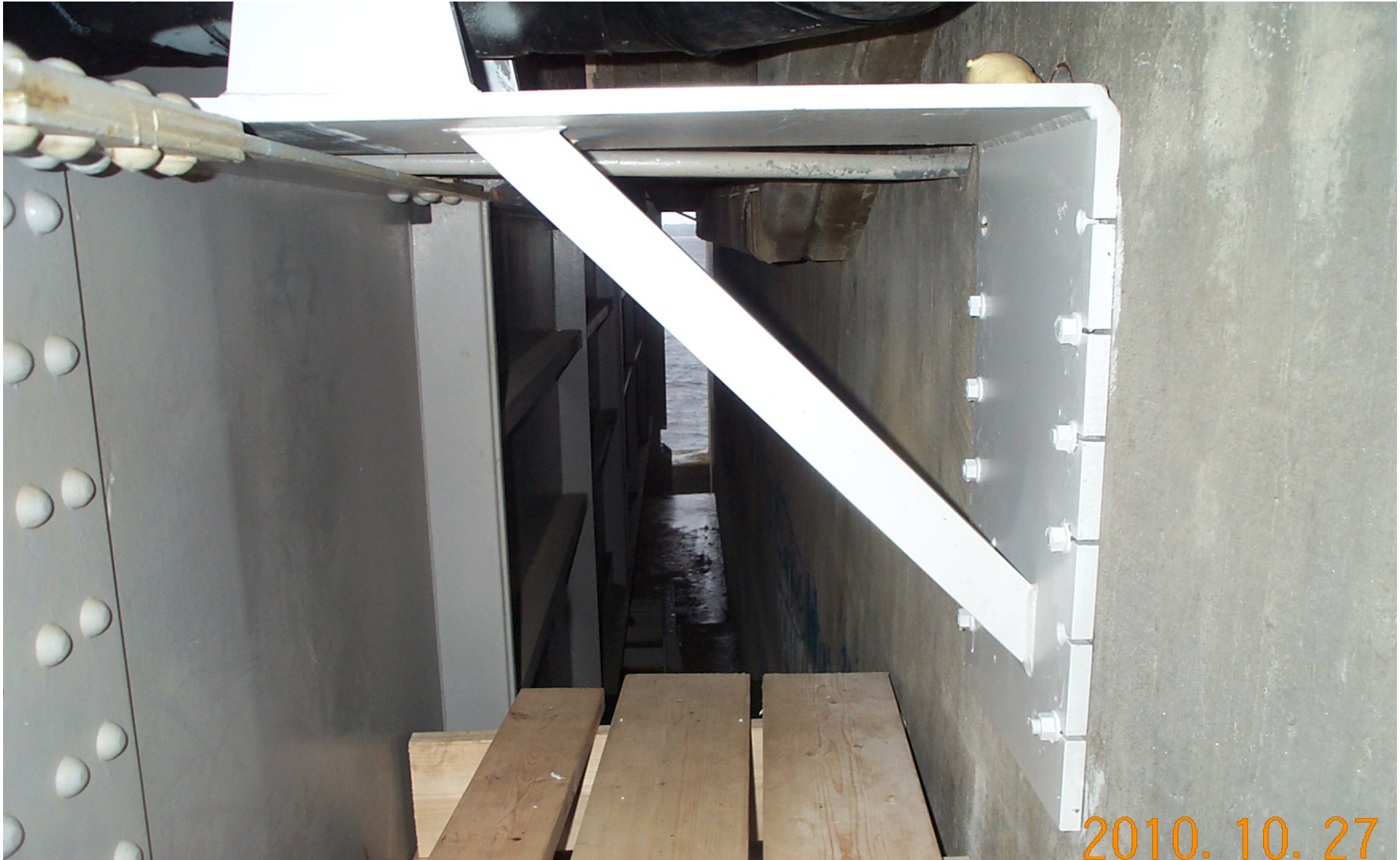
Fixering av rörledningen gjorde av Svetz i Strömsund
