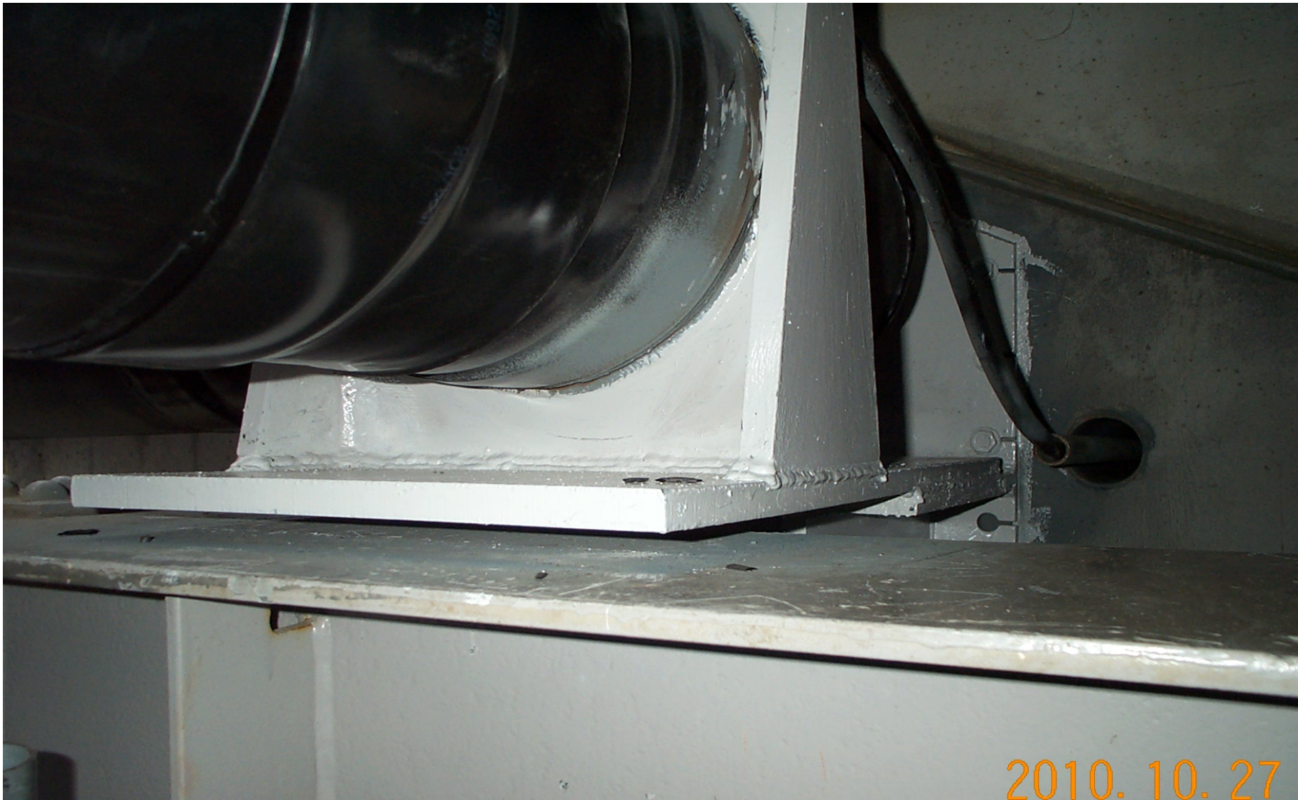
Detaljbild av infästningen
