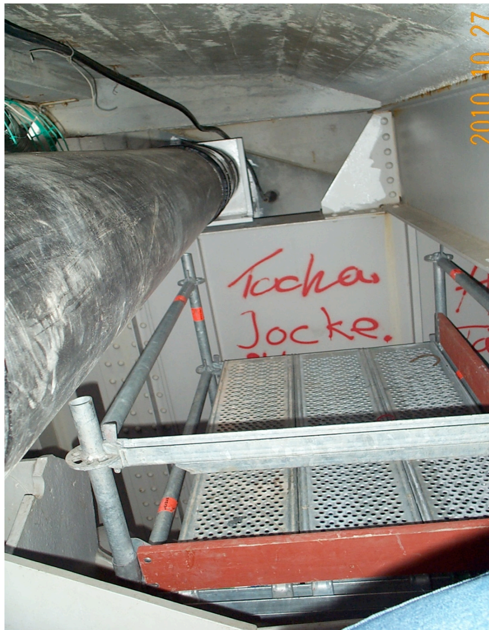
Fixering av rörledningen vid vardera brofästet.
