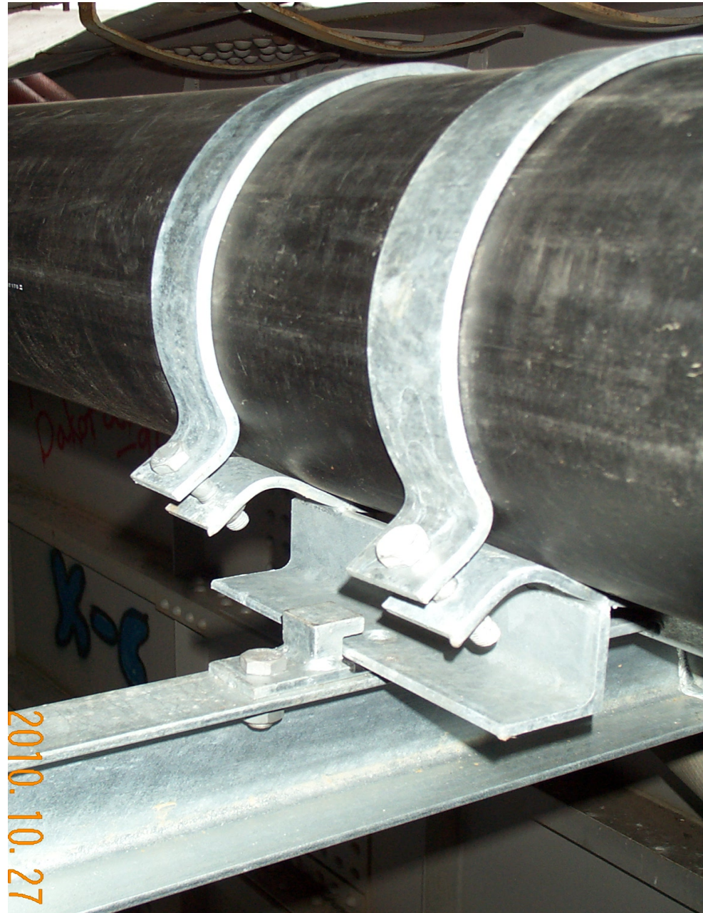
Glidskor används för att styra röret längsled så att det inte bildas s-kurvor.
