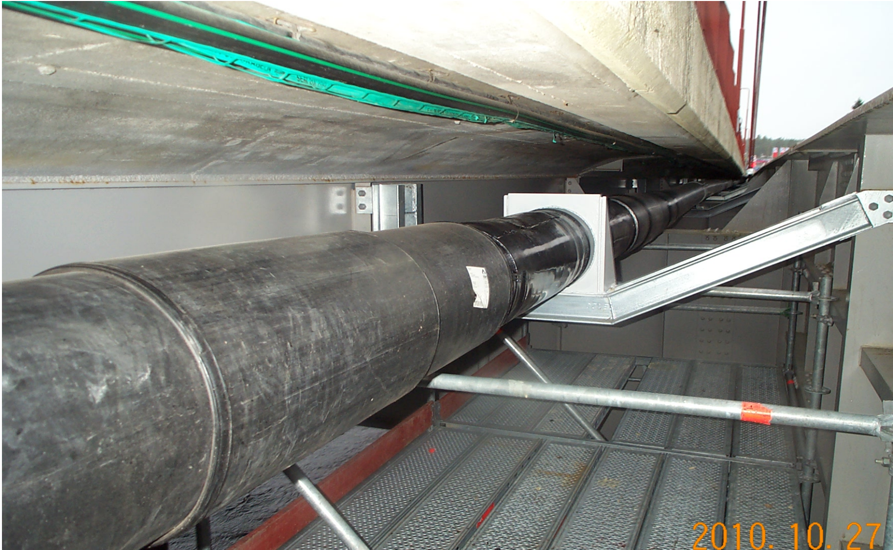
Fixering av rörledningen på samma ställe som bron är förankrad. C:a 1/3 från södra brofästet vid fundamentet.
