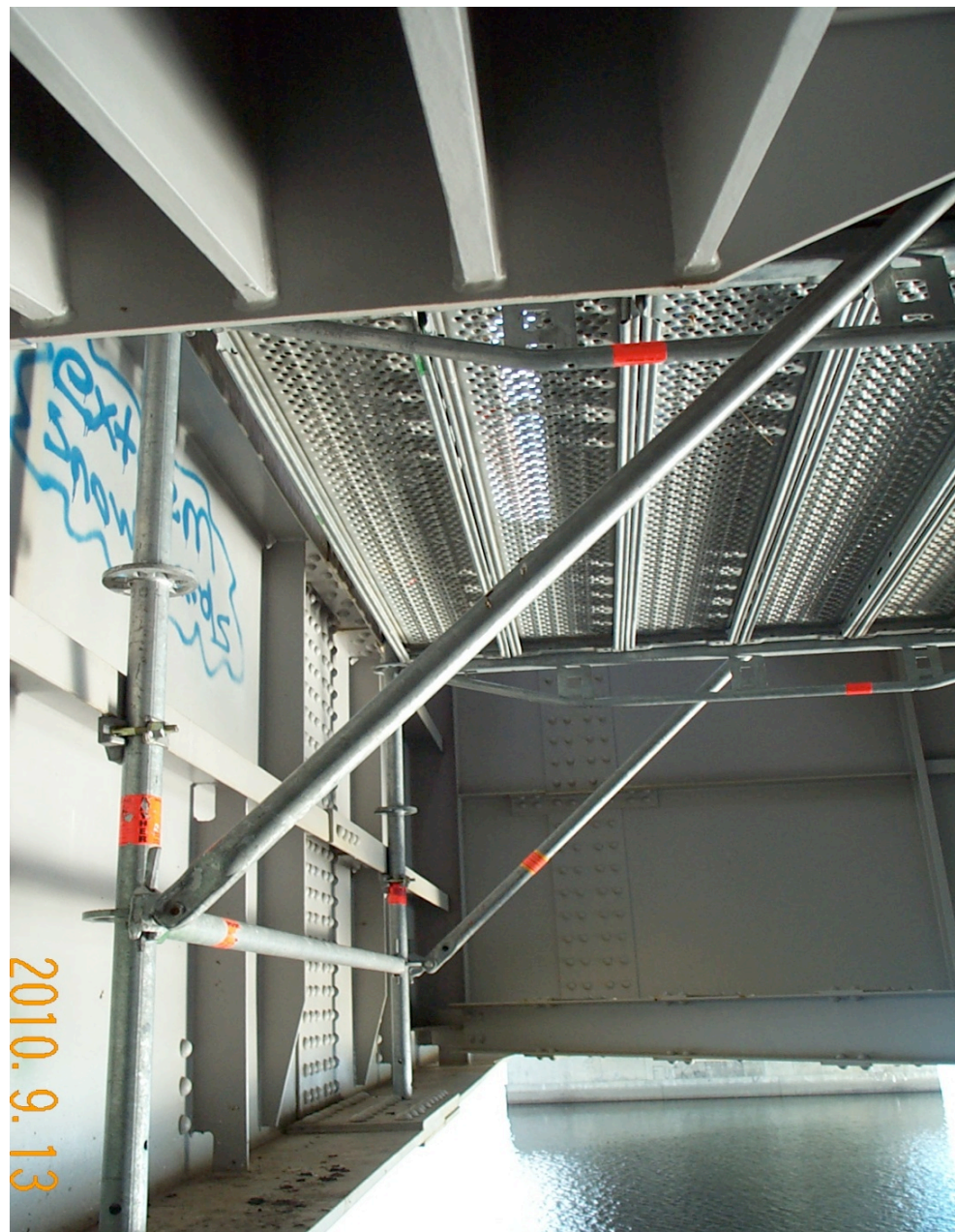
Ställningarna är utföra som plattformar med räcken (bilden visar underifrån)
