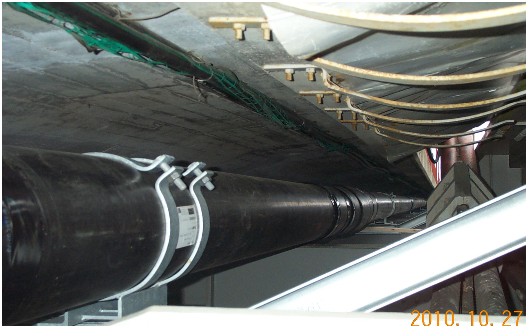
Rören på plats, muffade och rörupphängningen monterad
