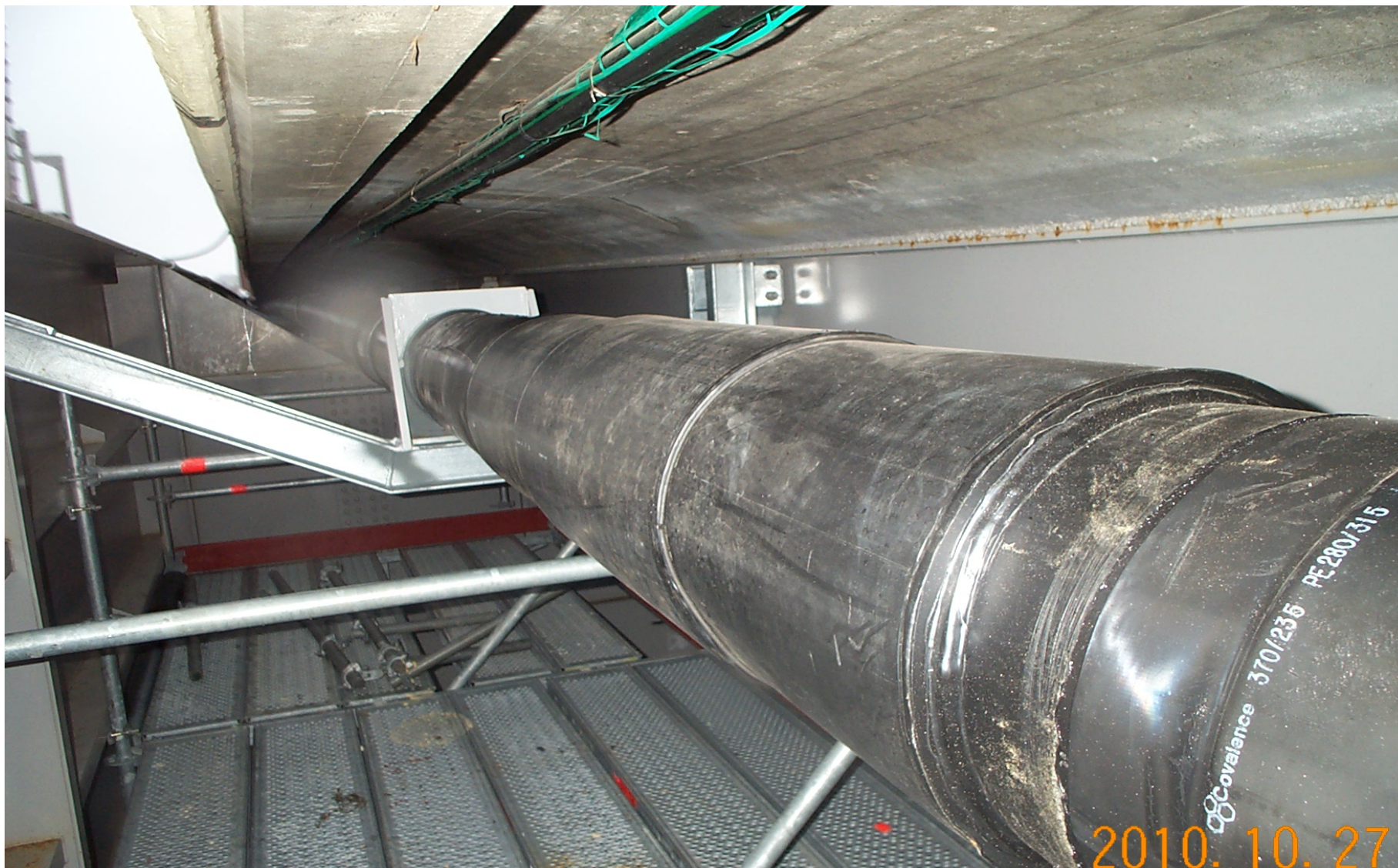
Fixeringen på bron samt en kompensator på varsin sida om den. OBS notera storleken plattformen.
